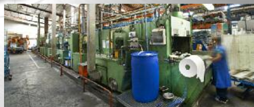
Ligne de dégraissage Entfettungslinie
